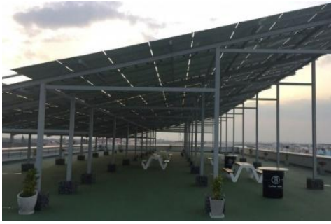
โครงการ Royal Can ติดตั้ง Solar Roof 5,000 kWp
