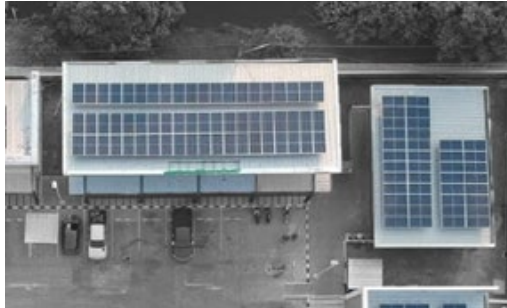
โครงการ PTG ติดตั้ง Solar Roof 1,659 kWp
