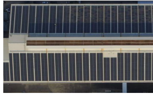
โครงการ SEAPAC ติดตั้ง Solar Roof 2,200 kWp
