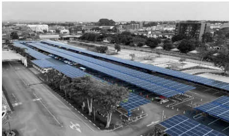
Solar Rooftop 999 kWp บริเวณที่จอดรถ สำหรับพื้นที่เปิดโล่ง ของโรงพยาบาล จ.ชลบุรี
