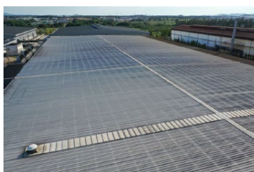
การสำรวจพื้นที่หลังคา
