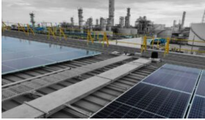
Solar Rooftop 750 kWp บนหลังคาโรงงานปิโตรเคมี (Petrochemical complex) ที่มีมาตรการความปลอดภัยสูง จ.ระยอง
