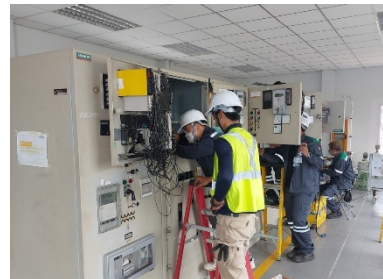
การเชื่อมต่อระบบโซลาร์เซลล์เข้ากับระบบไฟฟ้าภายในอาคาร (Shutdown and Tie-in)
