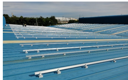
การติดตั้งอุปกรณ์จับยึดแผงโซลาร์เซลล์ (Mounting Installation)
