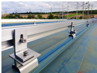
การติดตั้งอุปกรณ์จับยึดแผงโซลาร์เซลล์ (Mounting Installation)
