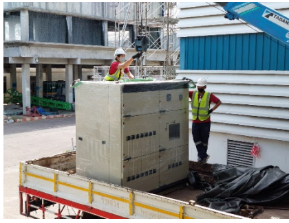
การติดตั้งตู้โซลาร์เซลล์ (Solar Controller Box Installation)
