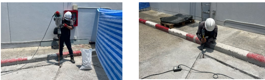
การติดตั้งระบบสายดิน (Ground System Installation)
