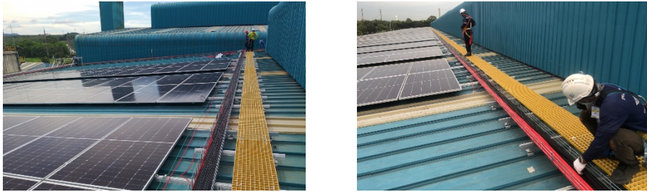
การเดินสายไฟ (Cabling)
