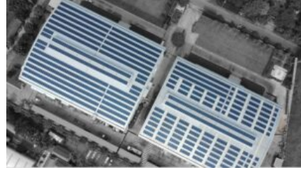
Solar Rooftop 531 kWp บนหลังคาโค้ง (Curved roof) ของ โรงงานอุตสาหกรรม จ.ปทุมธานี
