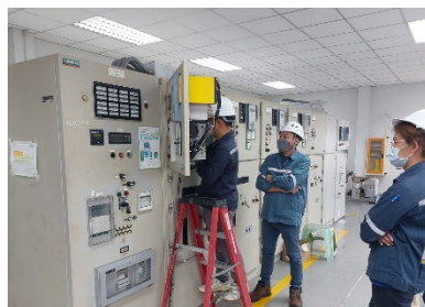
การเชื่อมต่อระบบโซลาร์เซลล์เข้ากับระบบไฟฟ้าภายในอาคาร (Shutdown and Tie-in)
