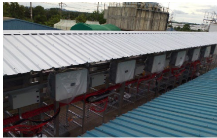
การติดตั้งเครื่องแปลงกระแสไฟฟ้า (Inverter Installation)
